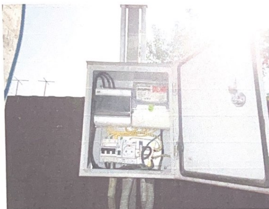
Фото 16, 17. Подключение дома к сетям электроснабжения
