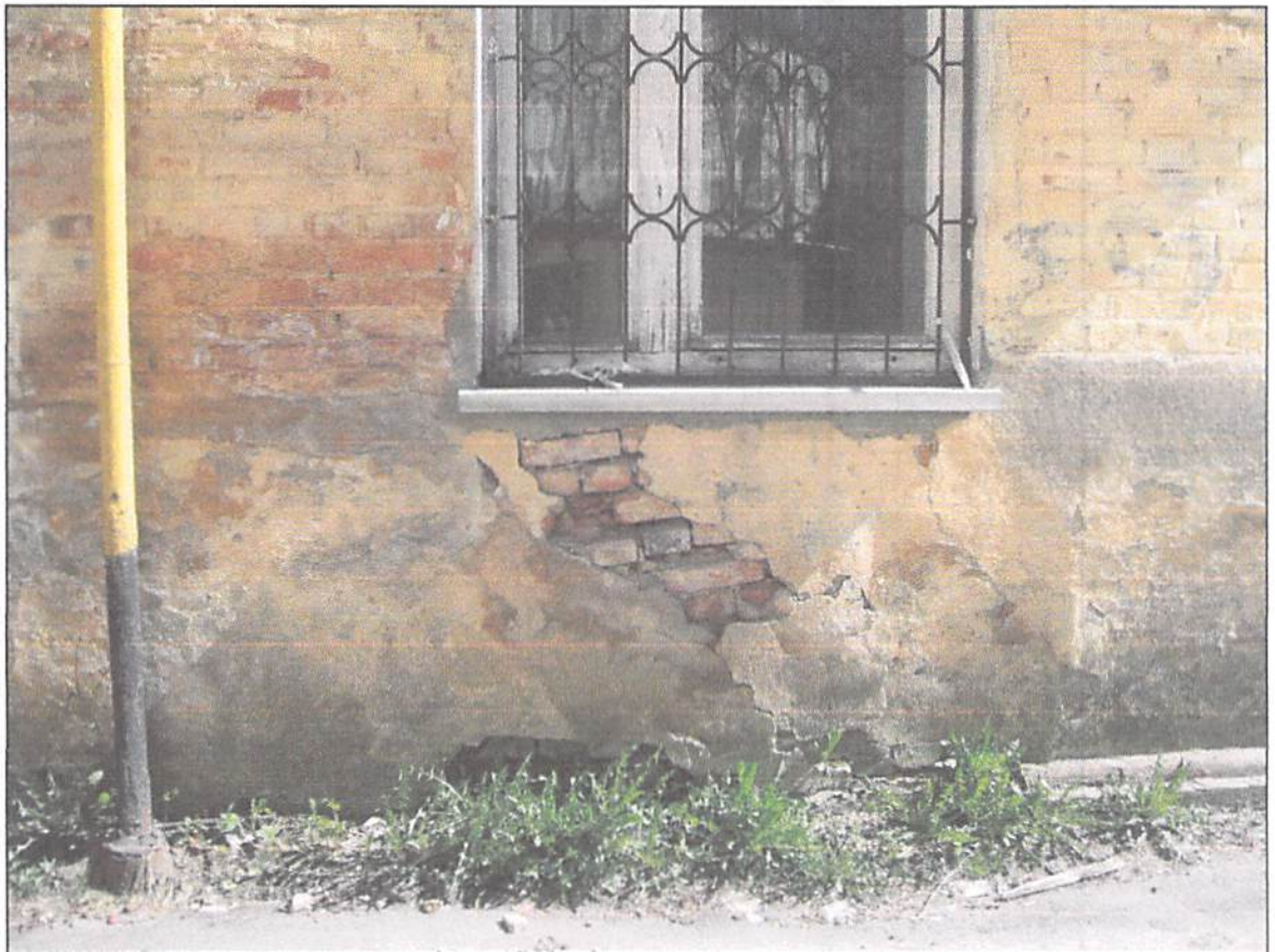
2. Фрагменты бокового (западного) фасада
